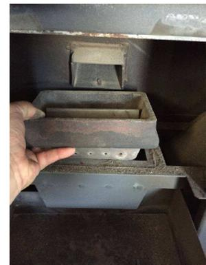
Deve essere effettuata con la stessa accuratezza anche la pulizia del condotto che si trova al di sotto del bruciatore in quanto è proprio attraverso questo che transita l'aria comburente.
