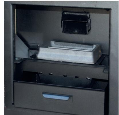
Nel caso in cui in camera di combustione si accumulino troppa cenere tale da causare un non corretto svolgimento della combustione, è necessario effettuare una pulizia manuale : si aspira la cenere dalla camera e si procede alla rimozione e alla pulizia del bruciatore.
